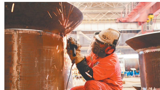
我国首个海上注碳增气技术示范应用项目海上平台开工建造场景。
