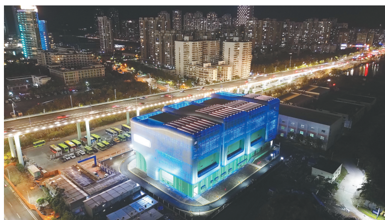
夜色中的海口220千伏碧海变电站。 通讯员 陈洋 摄
