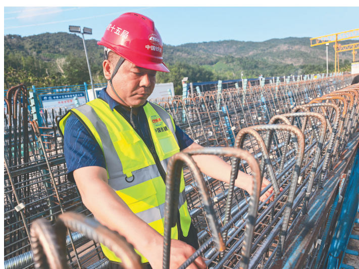
项目总工李自峰在复核钢筋骨架尺寸。通讯员 赵纯杰 摄
