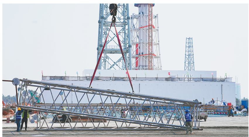
5月3日,在海南商业航天发射场二期项目现场,工人们正在进行避雷塔吊装的准备工作。(海南商发供图)
