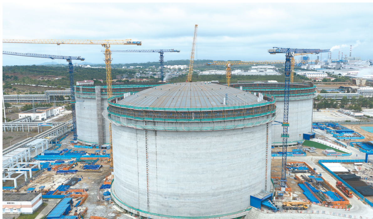
国家管网集团海南LNG二期工程建设现场,重达821吨的3号LNG储罐穹顶成功完成“气升顶”。 受访单位供图
