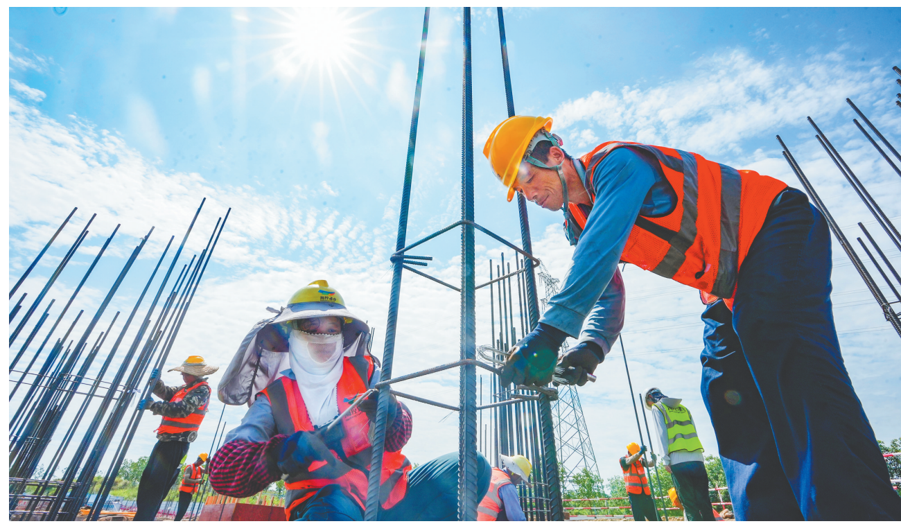
全力施工 抢抓进度
