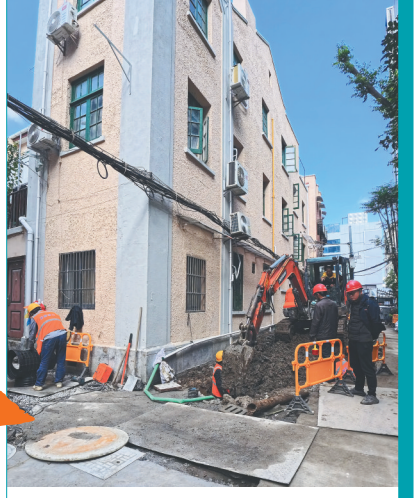
上海愚园路1407弄小区污水管道更新施工现场。新华社发
