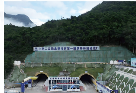
鹦哥岭隧道及连接线工程项目施工现场。 受访者供图
