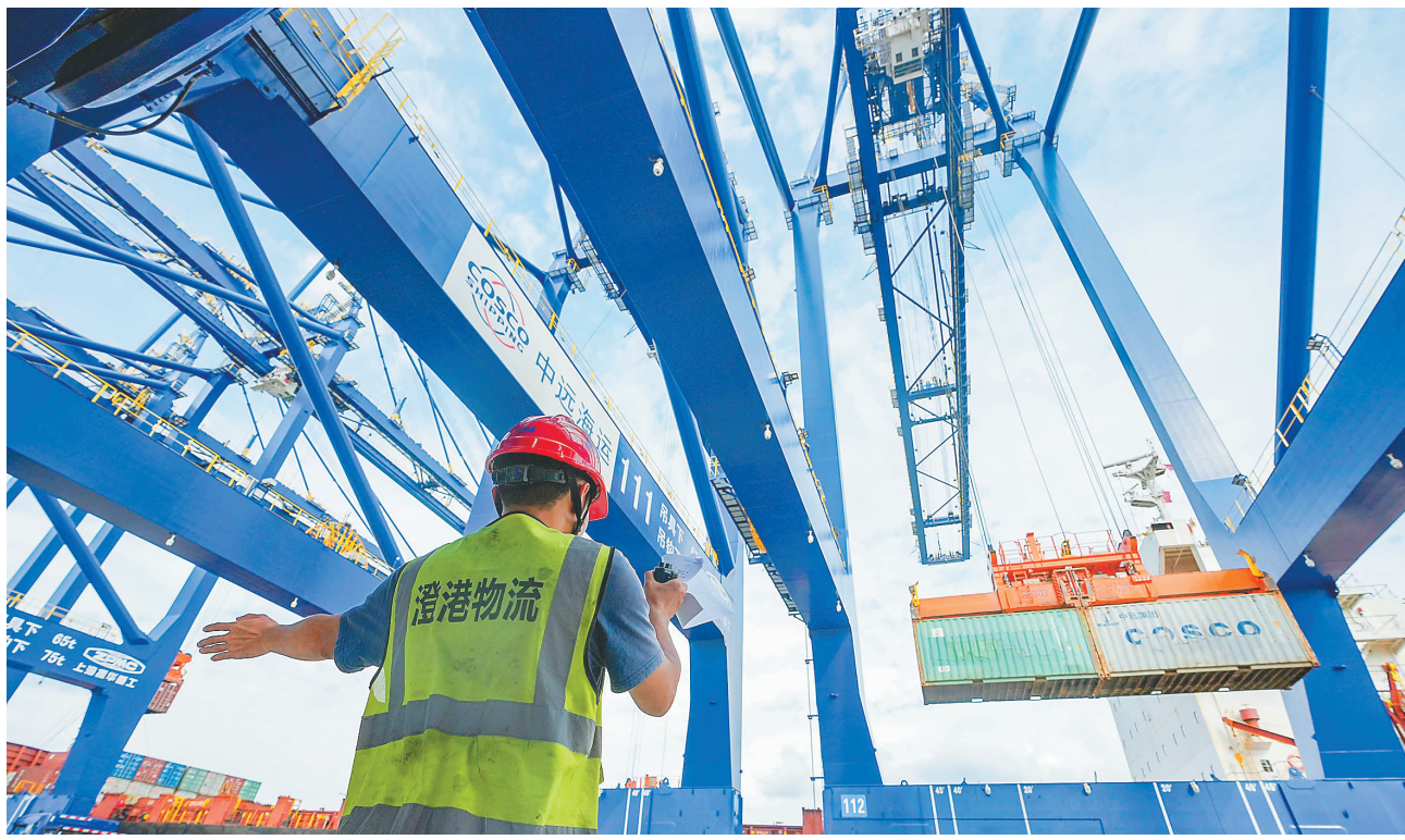
6月10日,洋浦国际集装箱码头,指挥手精准调度岸桥吊运集装箱,护航港口物流高效运转。海南日报全媒体记者 陈元才 摄
