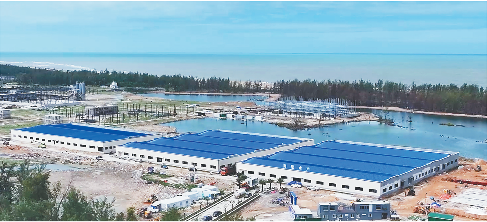
乐东南繁水产产业园项目施工现场。(乐东融媒体中心供图)
