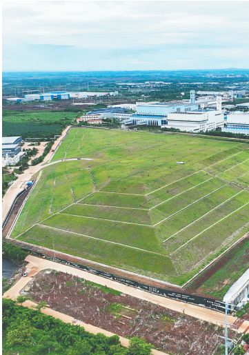
经过生态修复的颜春岭生活垃圾填埋场。 海南日报全媒体记者 陈元才 摄
