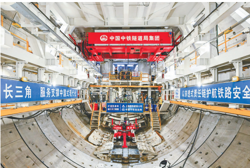
崇太长江隧道“领航号”盾构机施工现场。
