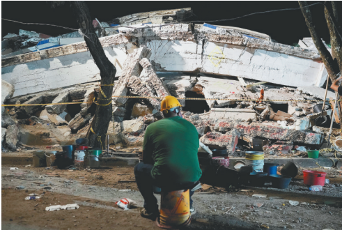
8月11日,在哥伦比亚卡利,一名男子坐在倒塌的建筑废墟旁。
