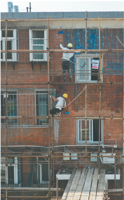
工人在唐山市路南区南厂楼小区改造项目施工现场粉刷墙体。
