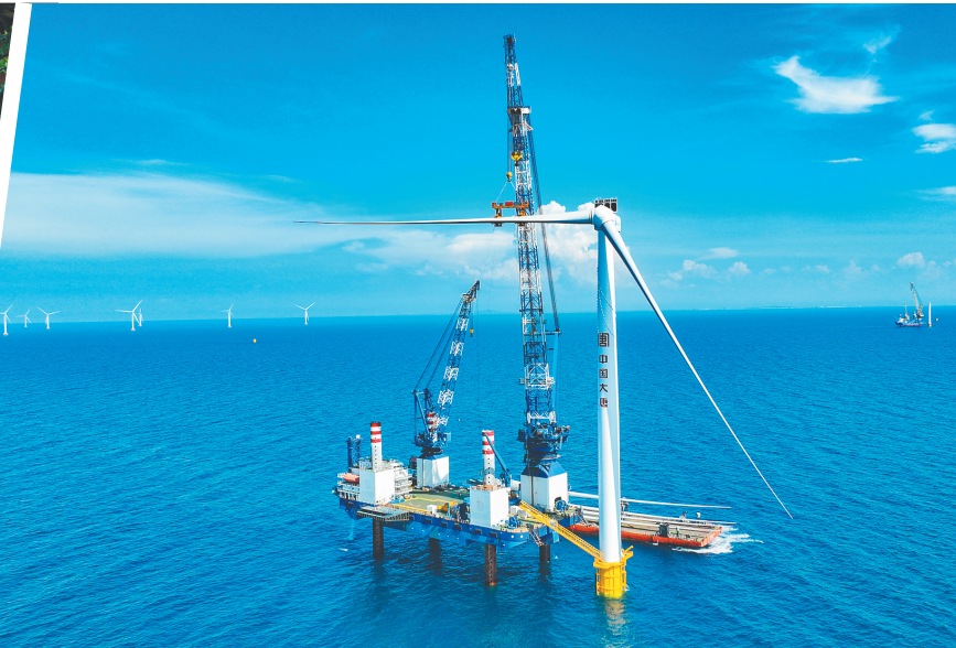
日前,位于儋州西北部海域的大唐儋州120万千瓦海上风电项目二场址,新的风电机组正在安装。 海南日报全媒体记者 陈元才 摄
