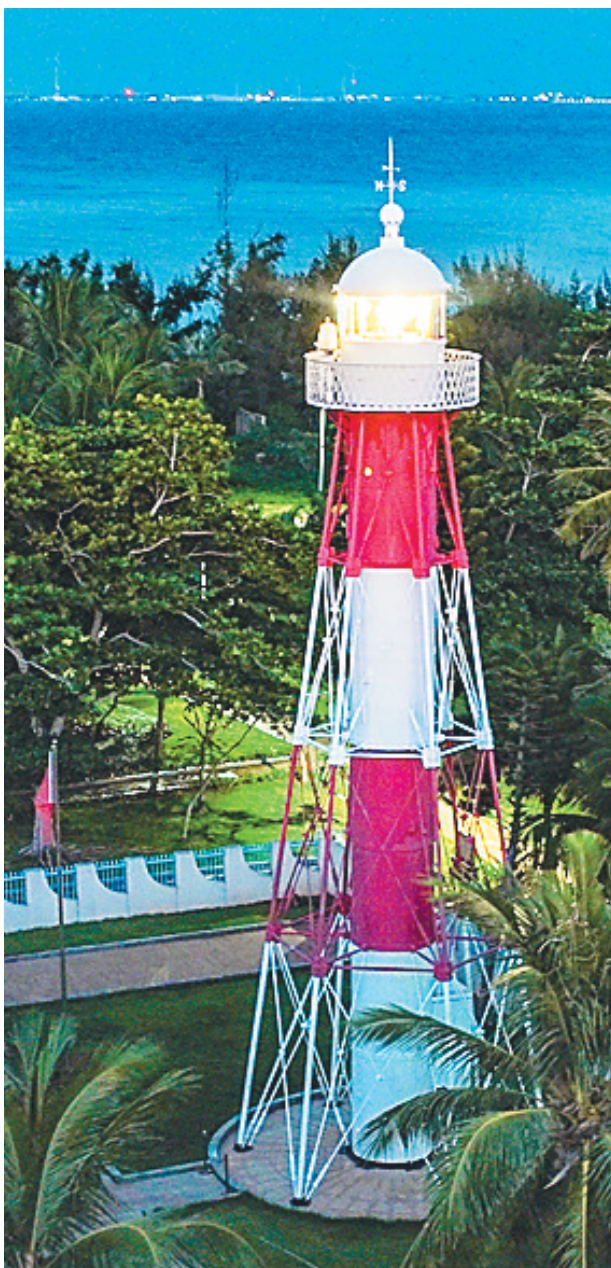
文化标识：临高角百年灯塔。海南日报全媒体记者 陈元才 摄
