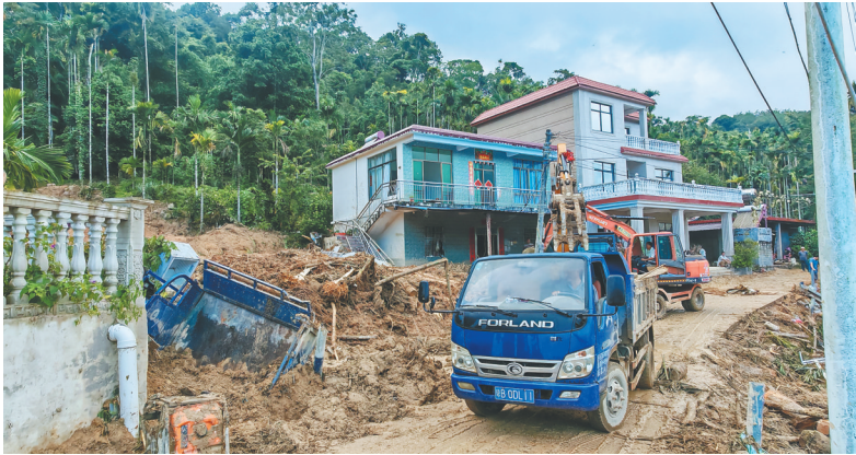
保亭响水镇毛岸片区，挖机清理倒伏的树木和淤泥，抢通村里的受阻道路。
