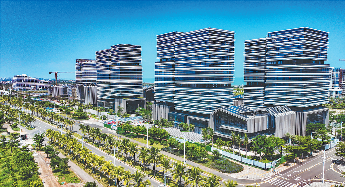
9月21日,海控·江东广场项目东、中地块已全部完工,片区整体形象全面亮相。海南日报全媒体记者 陈元才 通讯员 张梓宁 摄
