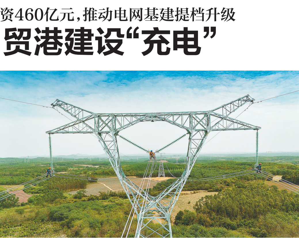
海南电网公司工作人员在海南500千伏三亚变电站工程项目线路上作业。 吴清炳 摄
