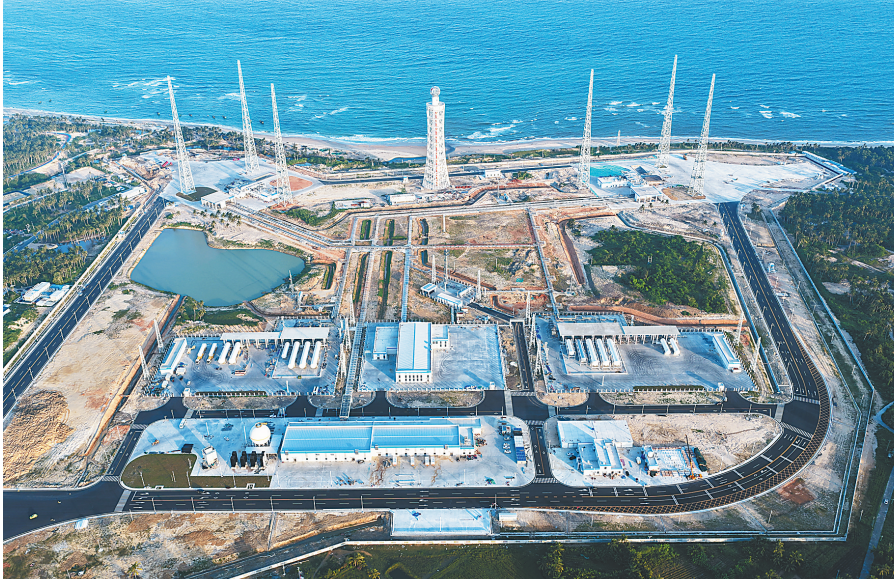
9月20日拍摄的海南商业航天发射场二期项目现场。通讯员 刘建秋 摄
