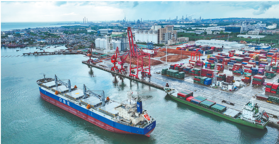
繁忙的洋浦经济开发区国投洋浦港码头。海南日报全媒体记者 陈元才 摄
