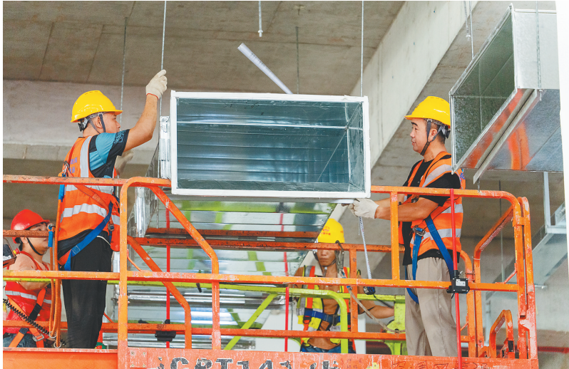
10月2日，昌农胡椒产业融合发展示范项目现场，工人在抓紧施工。 海南日报全媒体记者 袁琛 摄
