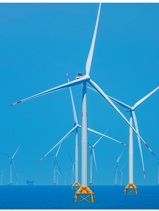
儋州市西北部北部湾海域大唐儋州 120 万千瓦海上风电项目。袁才 摄
