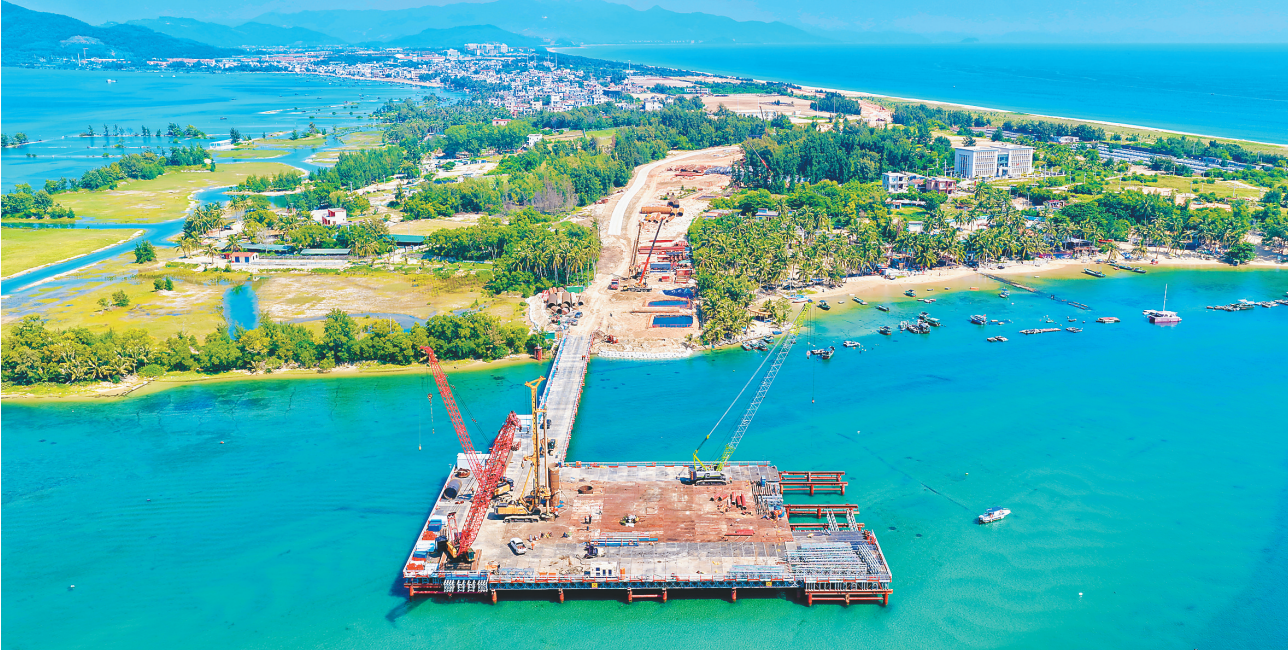
陵水黎安跨海通道及延长线工程主塔航拍，该桥采用独塔斜拉桥设计，全长390米。 海南日报全媒体记者 陈若龙 通讯员 巩锋 摄
