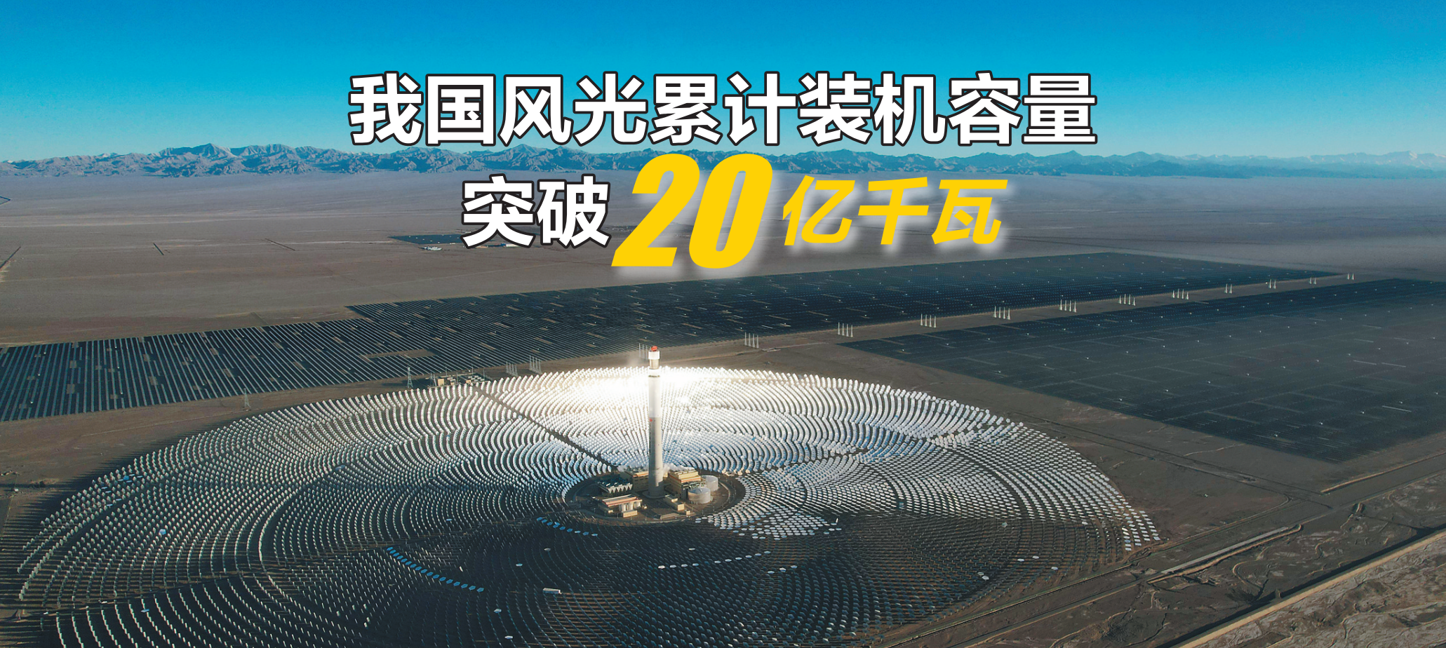
图为甘肃阿克塞汇东新能源光热+光伏试点项目。新华社发
