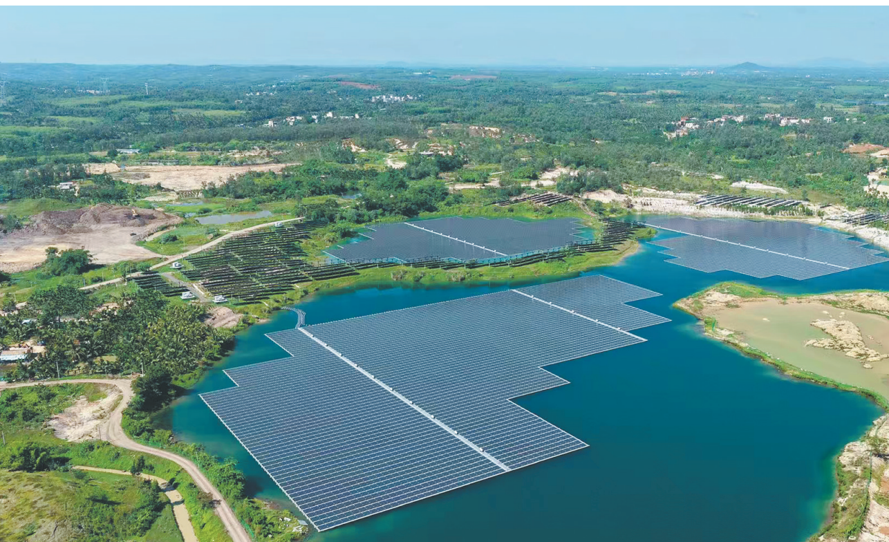
近年来，海南通过“矿山生态修复+产业导入”，将一个废弃矿坑重新利用。图为位于海口市琼山区甲子镇的长昌煤矿片区，该片区治理后引入光伏产业。（受访单位供图）
