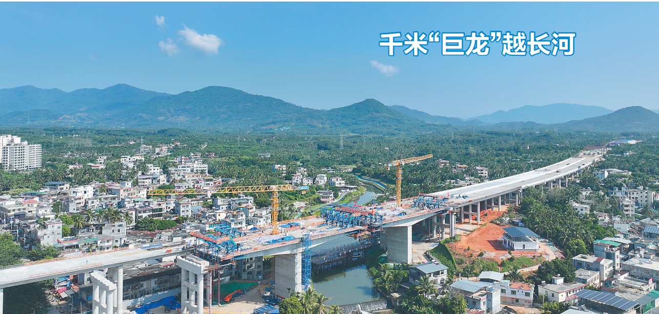
近日，G98环岛高速大三亚段扩容工程项目控制性工程三道特大桥幅悬浇段完成中跨合龙，成为全线首个实现悬浇箱梁合龙的标段。该桥位于保亭黎族苗族自治县三道镇，全长1368.54米，跨越田湊河及G224海榆中线。项目坚持生态优先、绿色施工，施工废水、基坑渗水统一收集经沉淀、除油等处理后达标排放。 文/海南日报全媒体记者 曹马志 图/海南交通集团
