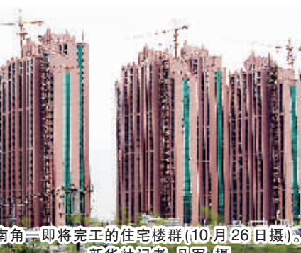
上海西南角一即将完工的住宅楼群(10月26日摄)。
