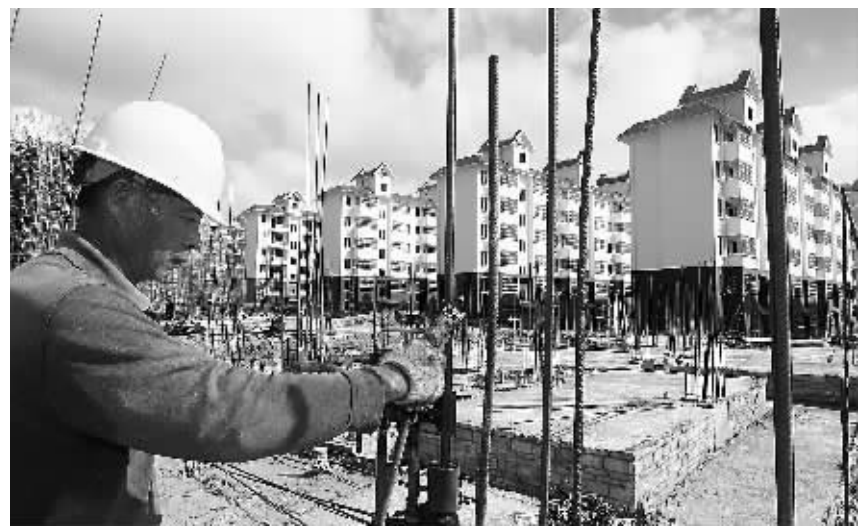
11月9日，一名工人师傅在焊接梁柱钢筋。昌江黎族自治县和兴家园保障性住房小区一期工程已收尾，二期工程已封顶，三期正在施工中。该小区将建保障性住房1204套。 本报记者 苏晓杰 摄
