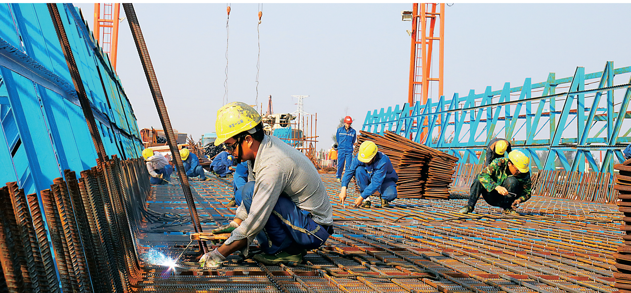
铺前大桥项目现场,工人们正在加紧施工。 通讯员 罗利明 摄
