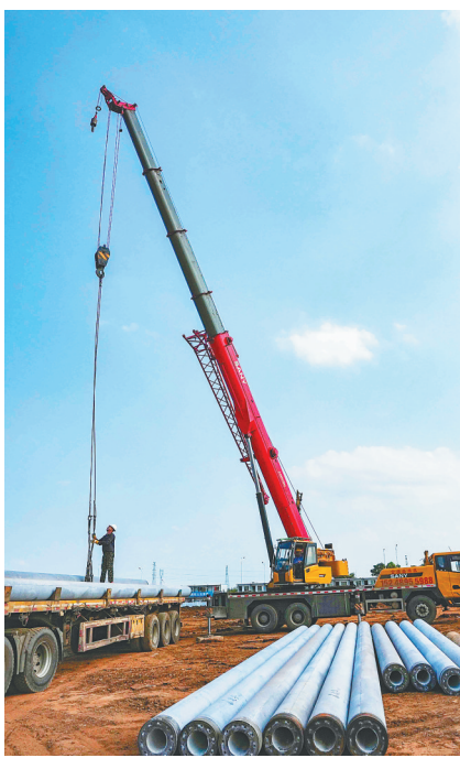
位于澄迈县金马现代物流园的京东澄迈电子商务产业园及运营结算项目二期工程施工现场,工程有序推进。 本版图片均由 袁才 摄
