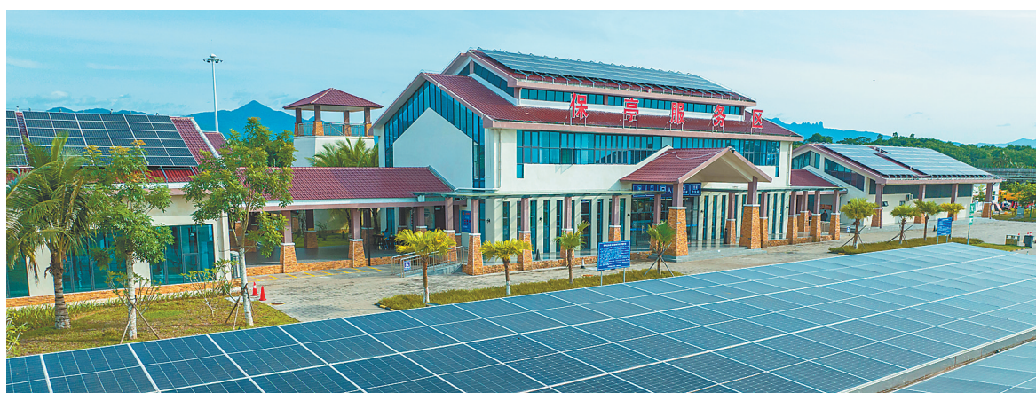
保亭服务区利用当地光照资源和光储技术，在实现光伏并网的同时完成“光储充”一体化建设，为海南清洁能源岛建设提供新方案。图为保亭“光储充”一体化低碳服务区。（资料图）
