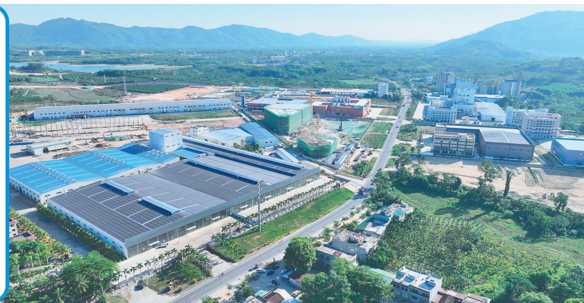
建设中的屯昌大同产业园，路网已初具雏形。林小丹 摄
