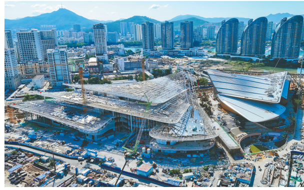
近日，位于三亚湾的海南国际文化交流中心项目，工人们在屋顶施工。海南日报全媒体记者 王程龙 摄
