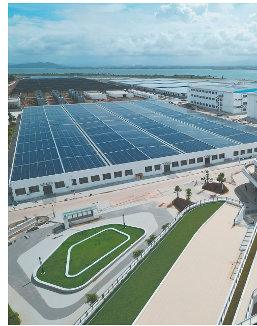
万宁市工厂化养殖产业园项目一期。海南日报全媒体记者 林博新 摄
