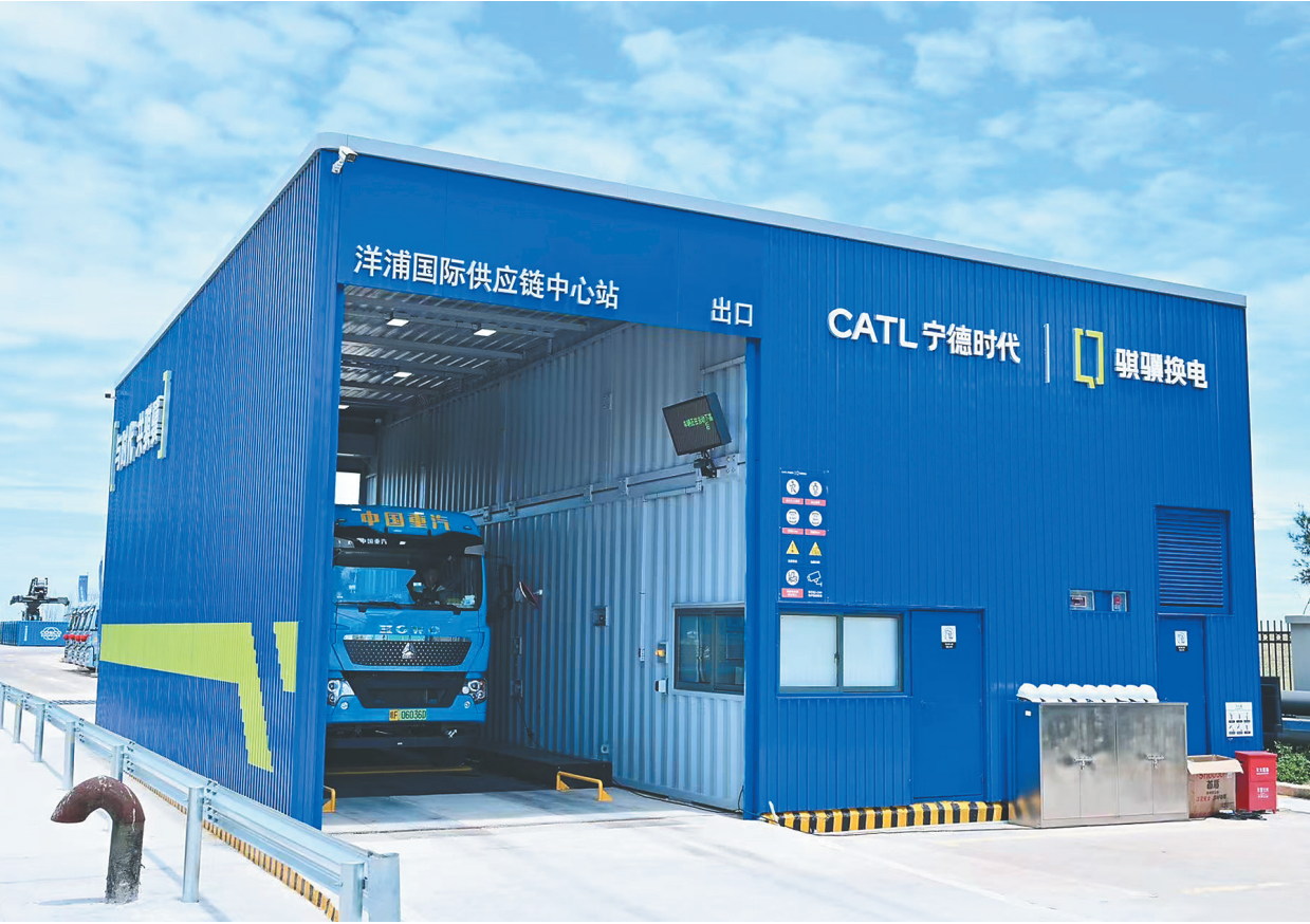
新能源重卡在洋浦骐骥换电站换电。海南日报全媒体记者 邵长春 摄
