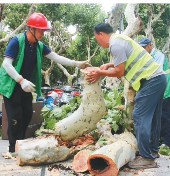
7月12日，绿化工人在江苏省苏州市姑苏区五州路上清理被大风吹倒的树木。
