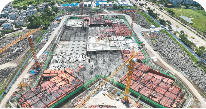
老城科技新城医院项目建设中。
