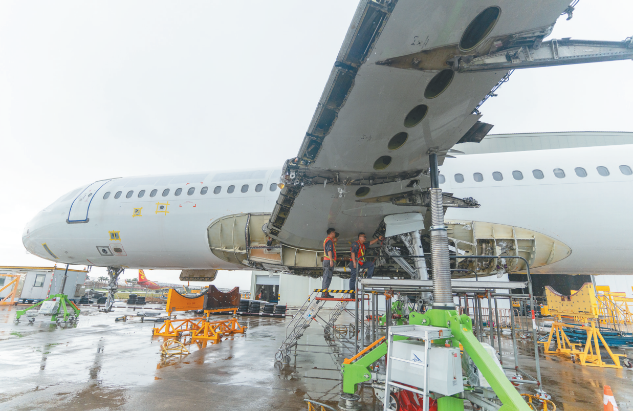
近日,在海口美兰国际机场新海航基地停机坪,海航技术旗下大新华飞维工作人员对飞机进行拆解。海南日报全媒体记者 袁琛 摄
