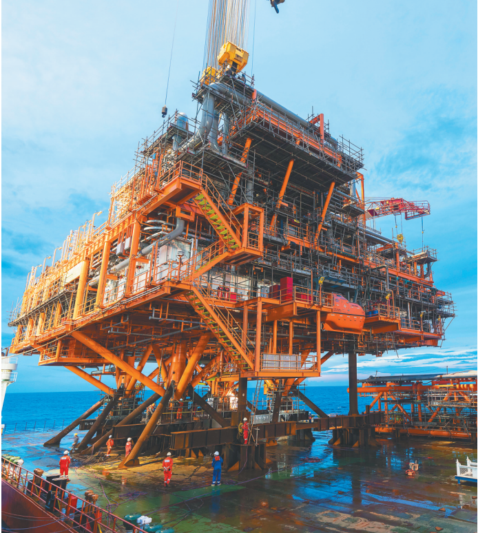
9月24日，作业人员切割上部组块固定桩，切割完毕后，主作业船将上部组块缓缓吊起。
