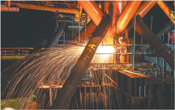
9月24日晚，作业人员正在切割上部组块固定桩。
