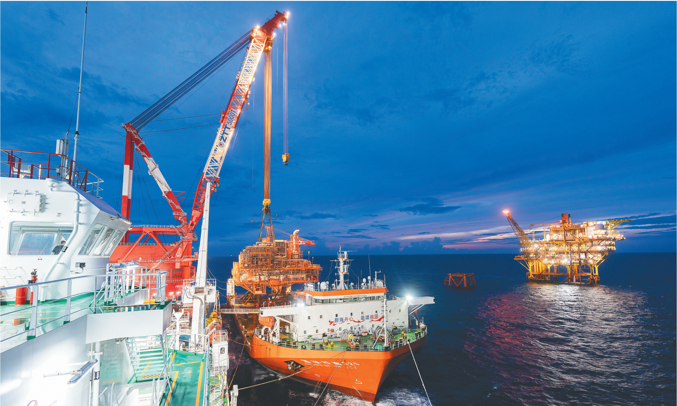
九月二十四日晚，主作业船吊机将上部组块缓缓吊起，平移至导管架上方，实现组块与导管架慢慢对接。
