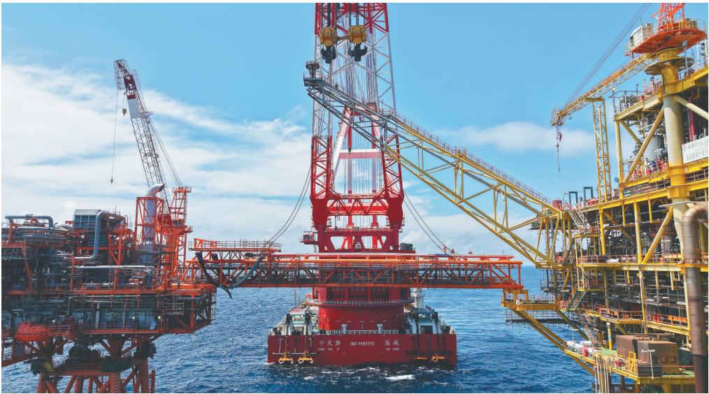
9月26日，工作人员开展新老平台的连接栈桥安装作业。
